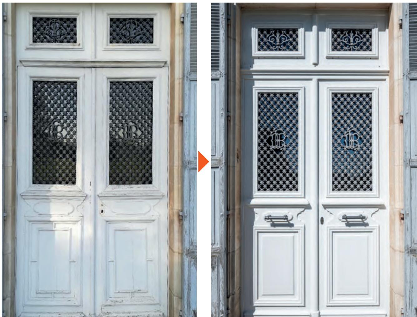
Ci-dessus, une réalisation de porte au plus proche de l'existant avec récupération de l'ancienne grille qui a été décapée, laquée et vernie pour être ensuite remontée sur la nouvelle porte Atulam.
